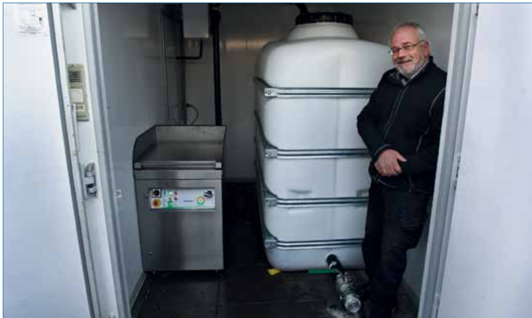
Leif Christensen, ansvarlig for skolens bygningsdrift, glæder sig over, at den nye madaffaldskværn og opsamlingskæbe til biogassen styrker elevernes grønne tankegang.
