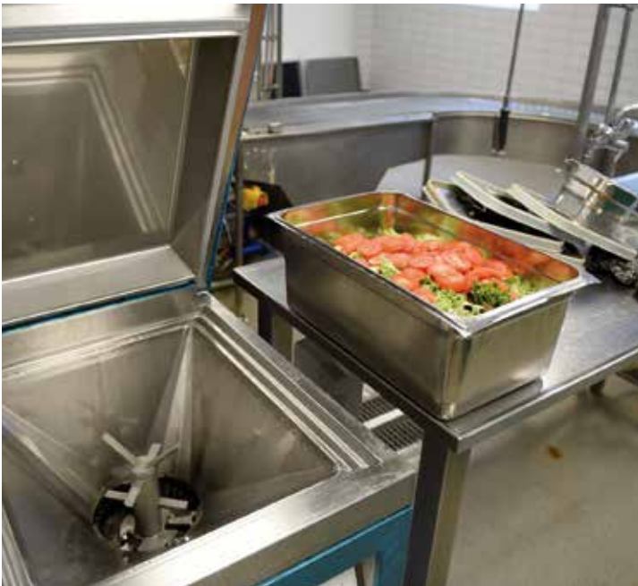
Billedet ovenover: Kværn på Bispebjerg. Tragten til affaldssystemet fylder ikke mere end en almindelig opvaskemaskine.
